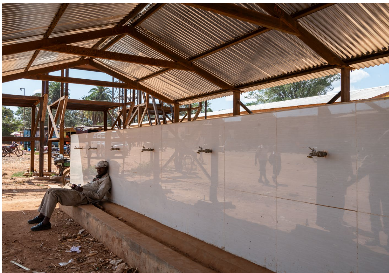
Sous-station d'eau potable en cours de construction dans le quartier de Luilu. | © Meinrad Schade.
